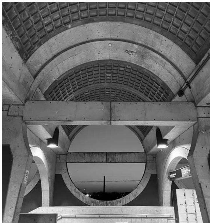
Figura 13. Hiroyuki Wakabayashi, estación del ferrocarril Keihan de la línea Uji, Kioto, Japón (2024). Fotografía: Sabrina Lobeira.
